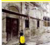
Na čištění fasád
